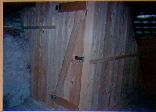
„Eulenstube“, Verschlag aus Nut- und Federbrettern mit Grundfläche ab 3 qm, Höhe mindestens 2 m.
