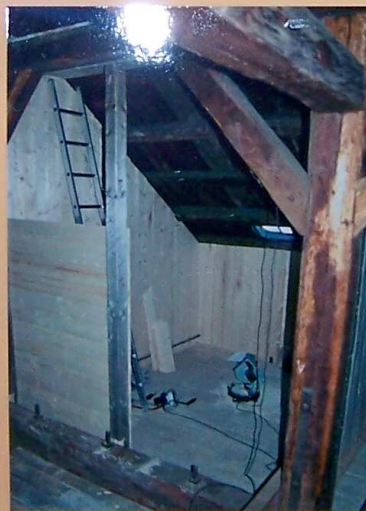
Hier ist eine sehr geräumige „Eulenstube“ im Bau.
