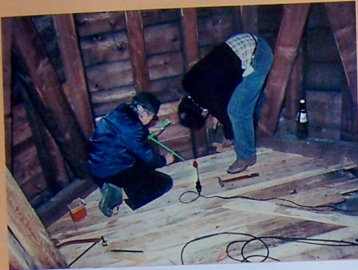
Einziehen eines Bretterbodens im Kirchturm oberhalb von Glocken und Uhr, so daß ein großer, ungestörter Freiraum für die Schleiereule entsteht.
