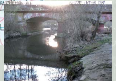
alte Usa Brücke
